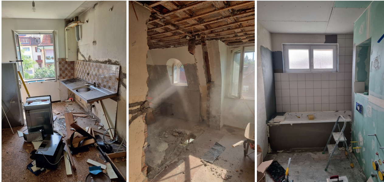
Eindrücke von der Küche-/Badsanierung an der Rieterstrasse. Fotos: Andrea Gheller
